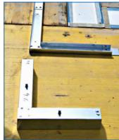
2 Die Einlegekänale werden auf die Grundplatten gesteckt. Um eine stabile Montage aller Teile zu erzielen, dürfen die Stösse nicht übereinander liegen. Die Teile werden deshalb durchnummeriert geliefert.
