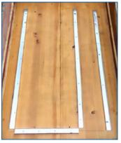
Zuerst werden die Masse auf der Holzschalung angezeichnet. Dann wir jede Grundplatte mit Nägeln befestigt.
