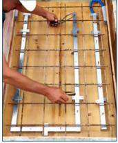
Der Einlegekanal wird mit der mitgelieferten Grundplatte und Alu-Nägeln auf die Schalung genagelt. Wir empfehlen, die Grundplatte mit dem Einlegekanal alle 40 cm zu befestigen. Das Einlegeprofil ist dann bereit für den Betonguss.
